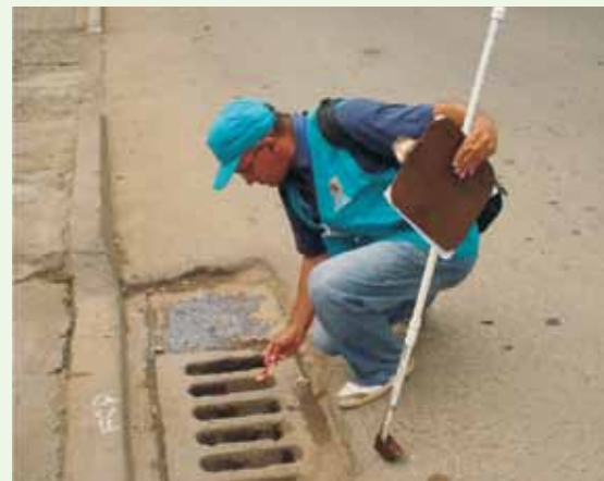
Figura 1. Proceso de inspección y tratamiento de sumideros de aguas lluvias
